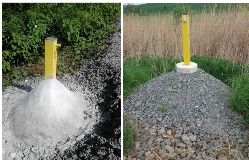
Obrázek 17 Řešení zhotovitele pro zvýšení stability zajišťovací značky
