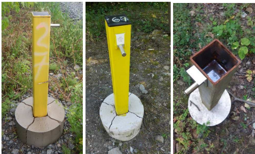
Obrázek 19 Popraskané betonové základy zajišťovacích značek ŽPSV
