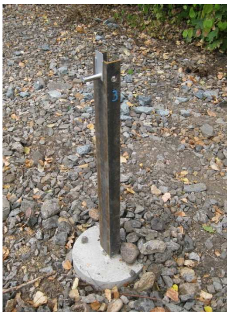
Obrázek 20 Otevřený profil konstrukce sloupku ŽPSV
